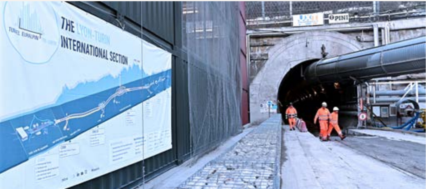
→ Chiomonte, Italia / Imbocco della galleria Maddalena 1 presso il cantiere CO03
