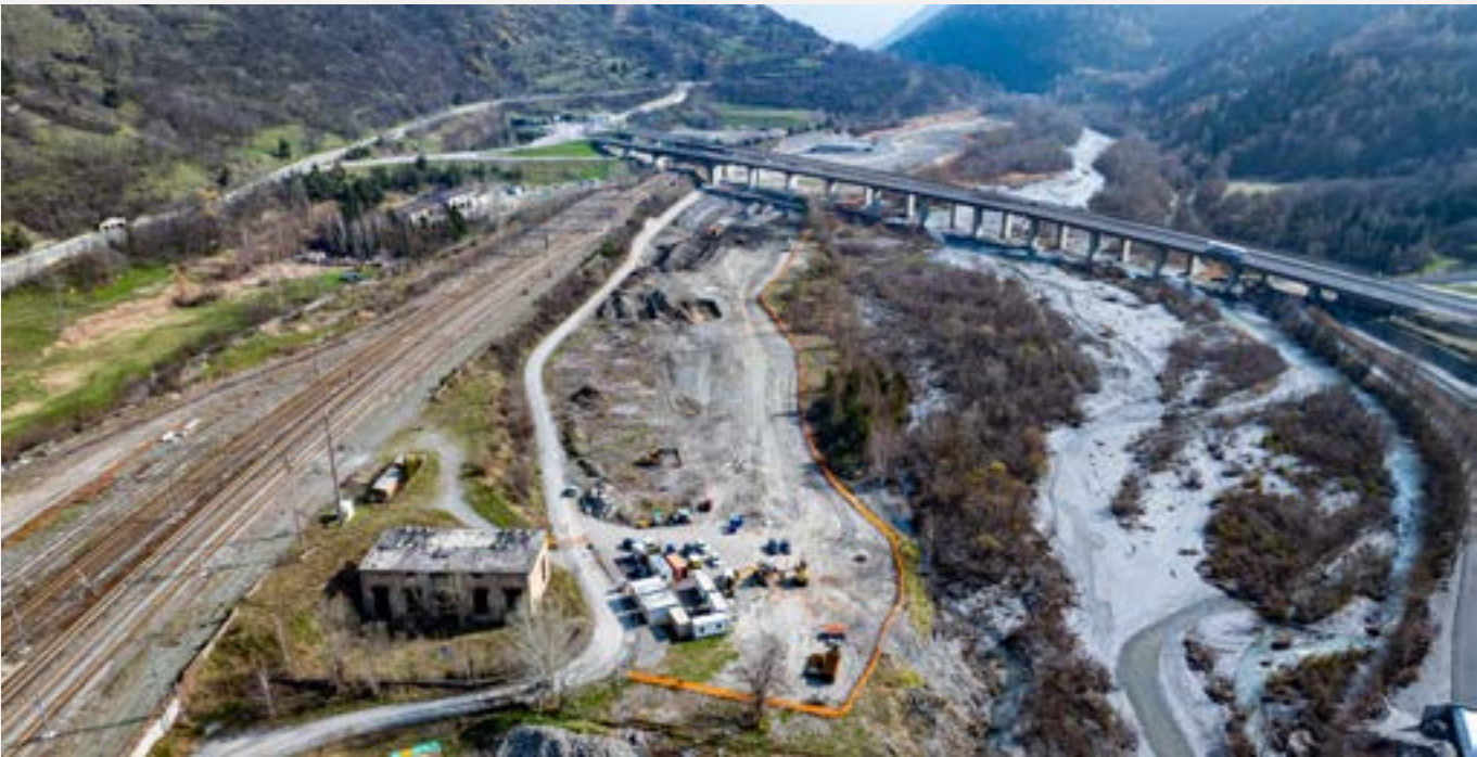
➔ Salbertrand, Italia / Vista aerea del cantiere CO10
