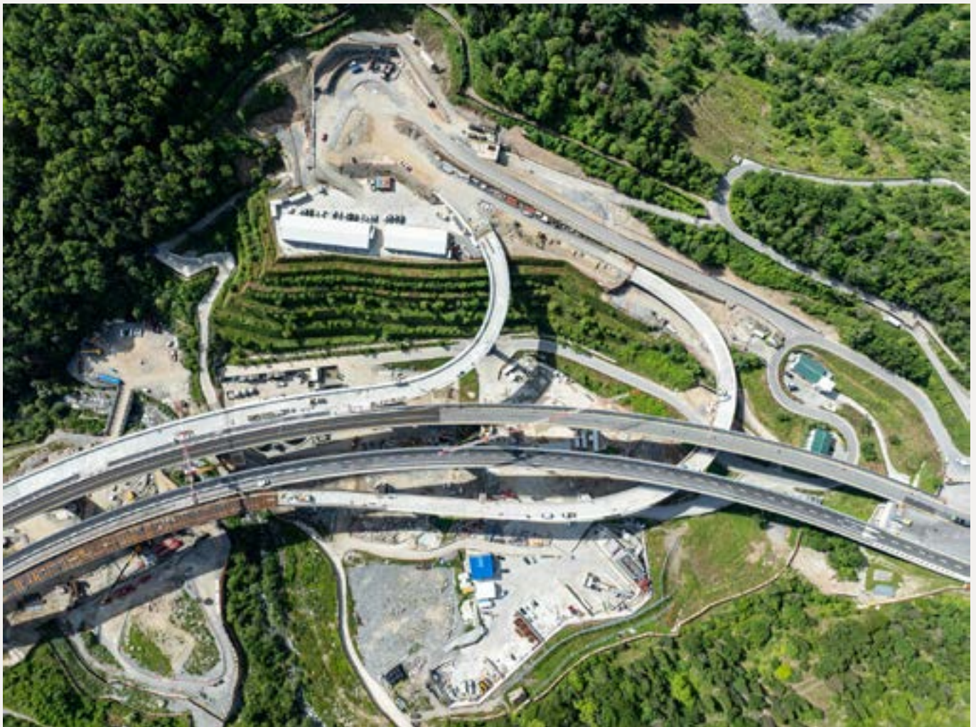
→ Chiomonte, Italia / Vista aerea del cantiere CO03/04 con il nuovo svincolo autostradale
