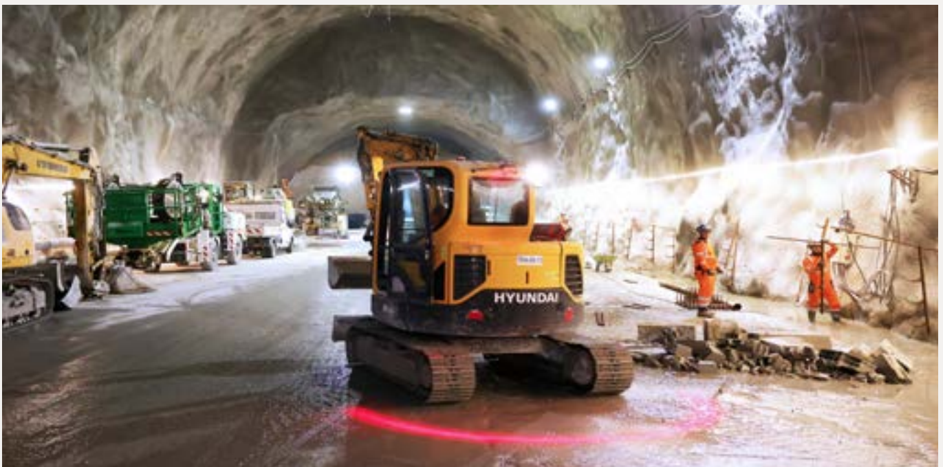
➔ Modane, Francia / Mezzi al lavoro in galleria con luci di segnalazione per ridurre il rischio di incidentalità
