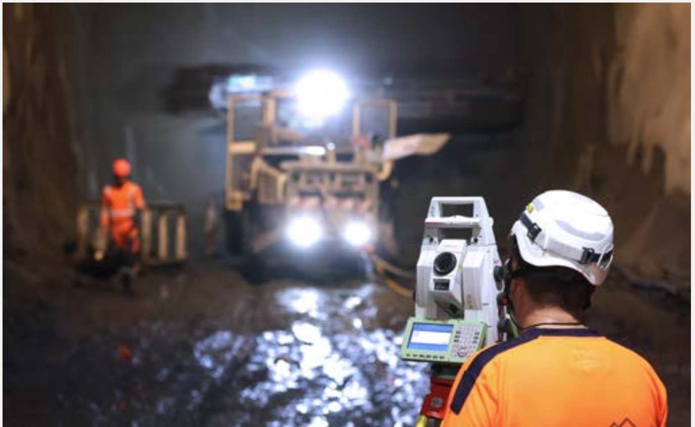
→ Saint-Julien-Mont-Denis, Francia / Misurazioni in sotterraneo nel corso dei lavori in tradizionale
