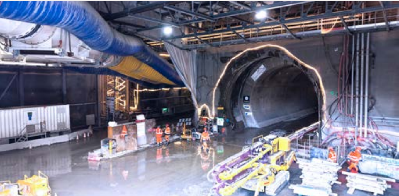
→ Saint-Julien- Mont-Denis, Francia / Imbocco del tunnel di base
