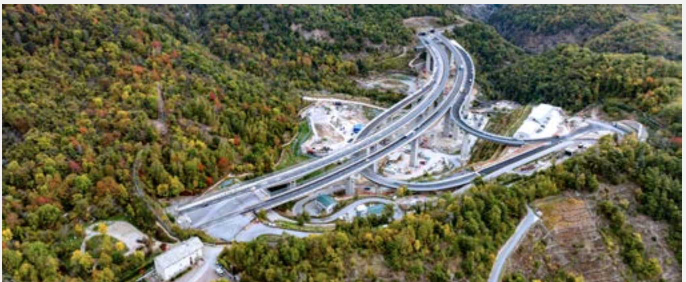
→ Chiomonte, Italia / Vista aerea del cantiere CO03/04 con il nuovo svincolo autostradale
