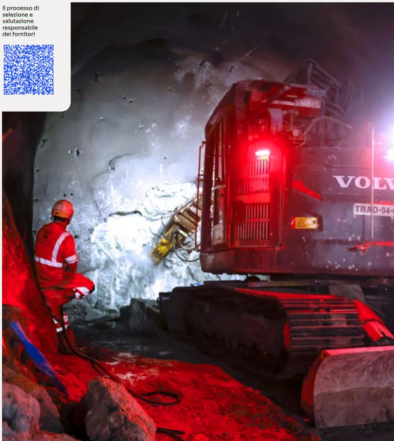
→ La Praz, Francia / Operaio monitora i lavori di scavo in tradizionale
